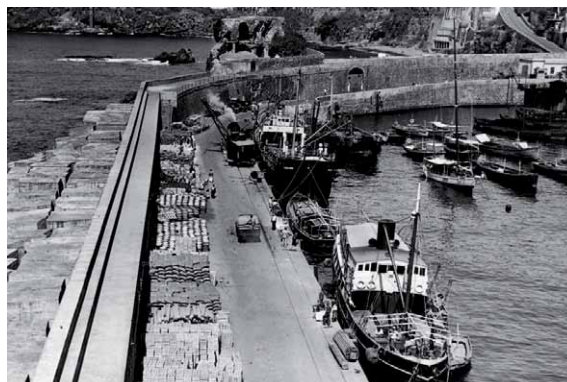
Figura 5 - Cais de ligação ao ilhéu de Nossa Senhora da Conceição
